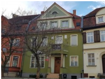
Siedziba Wydziału Zamiejscowego w Jeleniej Górze
